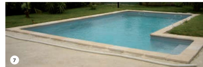
7 Mise en eau : Remplissez la piscine et mettez en place les brides d'étanchéité des pièces à sceller.
