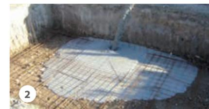
2 Coulage du radier : Coulez la dalle avec du béton dosé à 350 kg/m<sup>3</sup> (norme B25)
