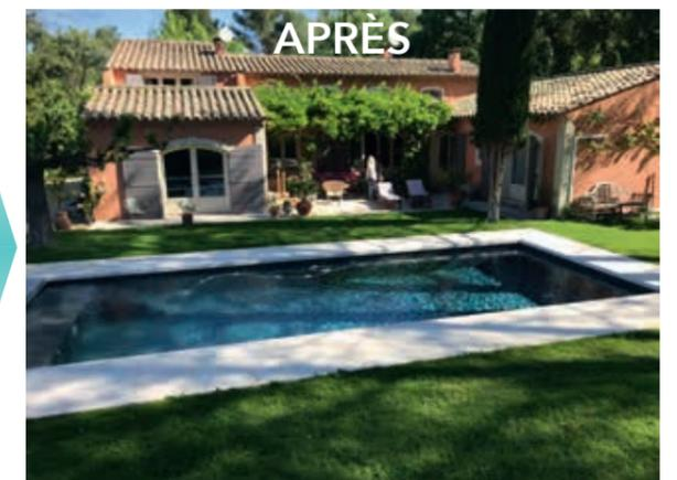
Rénovation d'une piscine de 8,00M x 4,00M, avec extension de la longueur sur 2,50M, remplacement des skimmers et des pièces à sceller, reprise du réseau hydraulique, pose d'un revêtement en membrane armée 150/100ème, d'un volet roulant avec caillebotis immergé, remplacement des margelles, remise à neuf du système de filtration, pose d'une pompe à chaleur 13Kw et création des plages autour du bassin.
