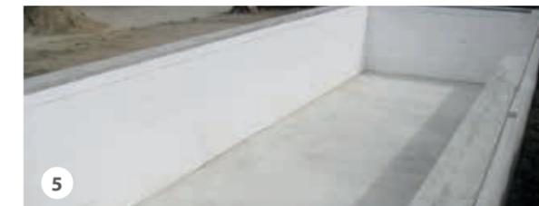
5 Arasement des parois : Il permettra de recevoir le profil d'accrochage du liner ainsi que les margelles.
