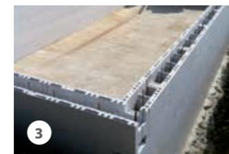
3 Montage des blocs : Les blocs seront emboîtés les uns dans les autres grâce à leurs tétons.
